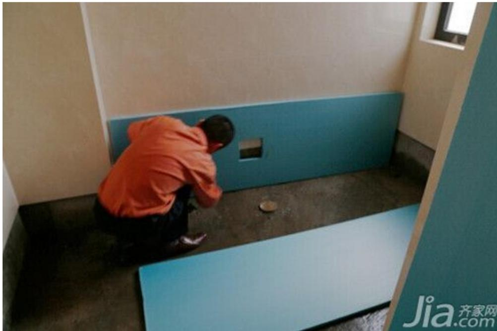
到达现场后，卫浴间的墙砖已经铺装完毕，地面也已经完成了找平和防水工程。地暖工作人员很顺利地开始了地暖铺装工作，这一层看似普通的蓝色泡沫塑料是什么呢？事实上，我们最担心的就是暖气来得慢、散的快，而这层板就是起到保温作用的保温板。工作人员根据并卫浴水槽凿洞，将地面铺满。
