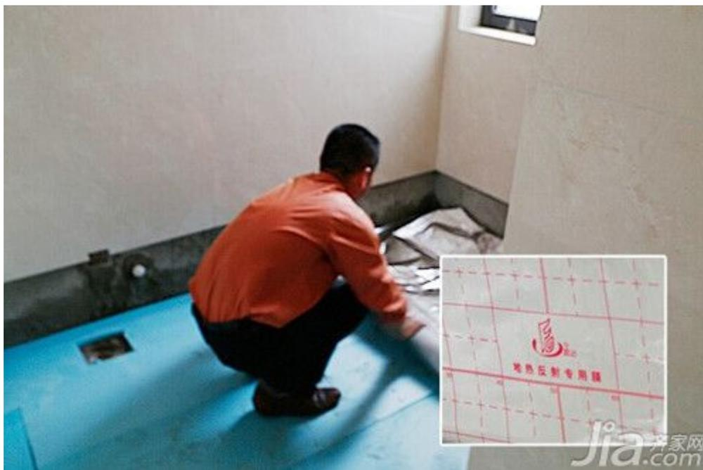
在保温板上再铺上一层热能反射膜，保证不让热量流失。
