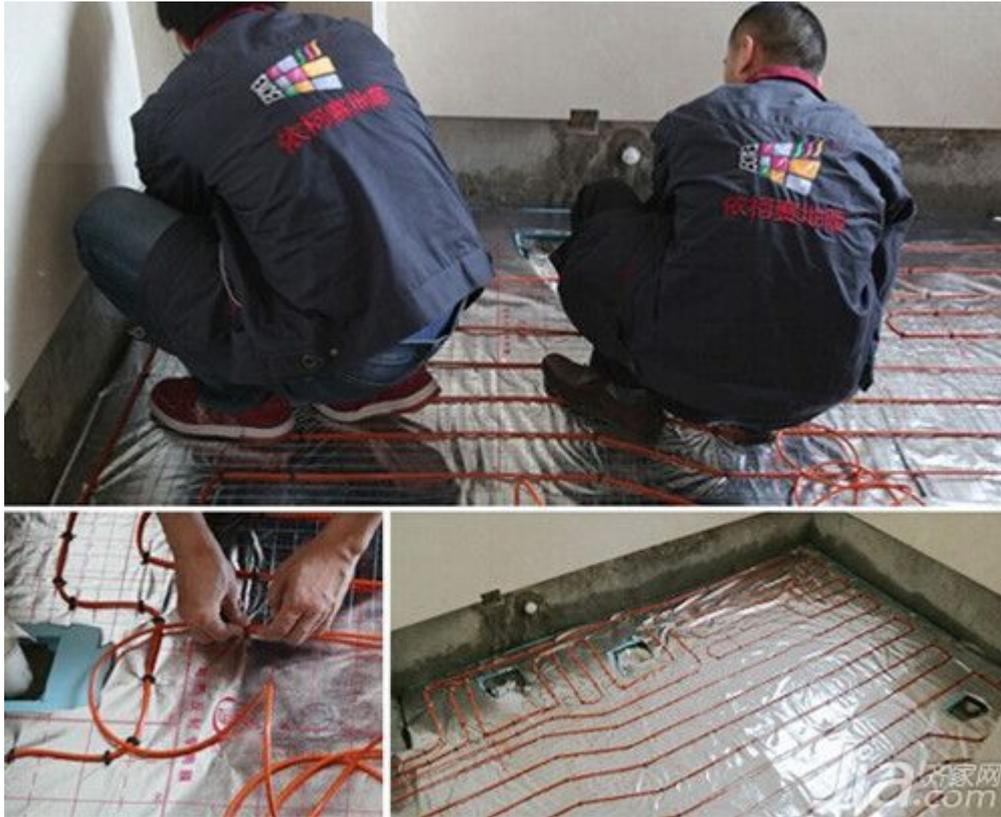
最后再铺设与面板相连的探头和底线。其中，黑线是探头的线，布置到钢丝网上，主要探测地表温度，接到温控。白色线是地线。到这里，第一轮的安装工作已经结束。
