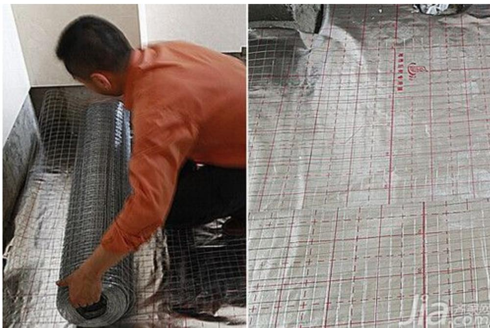
接下来，在中间地区铺设镀锌钢丝网，可以有效的防静电并起到固定作用，加上塑料夹固定。然后，工作人员开始沿着边缘循环铺设碳纤维，这里需要注意的是线与线之间的距离一般是10到12公分。整个电地暖的核心就是依靠碳纤维发热，发热稳定，铺设时用塑料夹固定。
